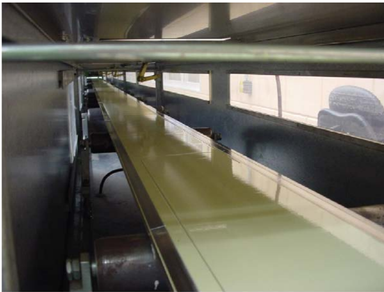
Abbildung 6: Innenraum mit Stahlband
