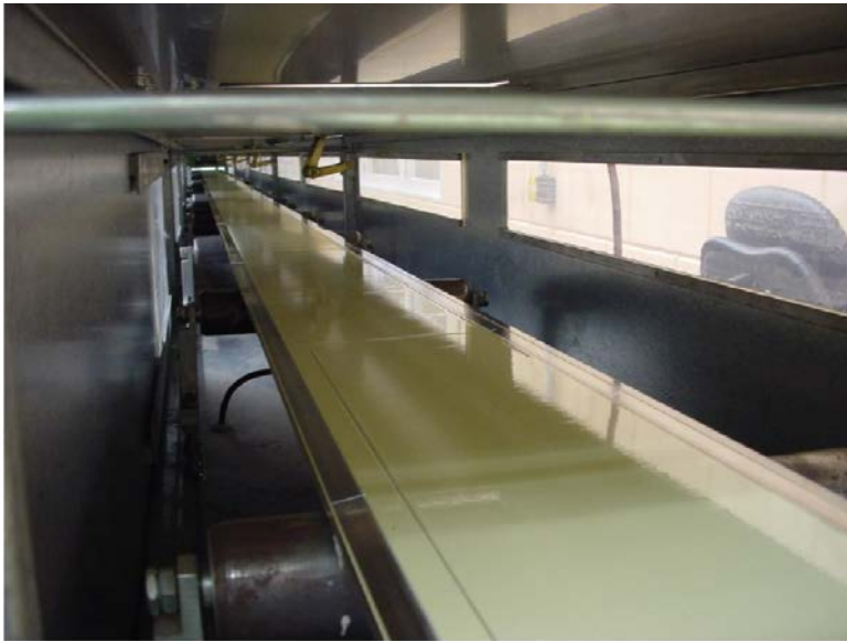
Abbildung 6: Innenraum mit Stahlband
